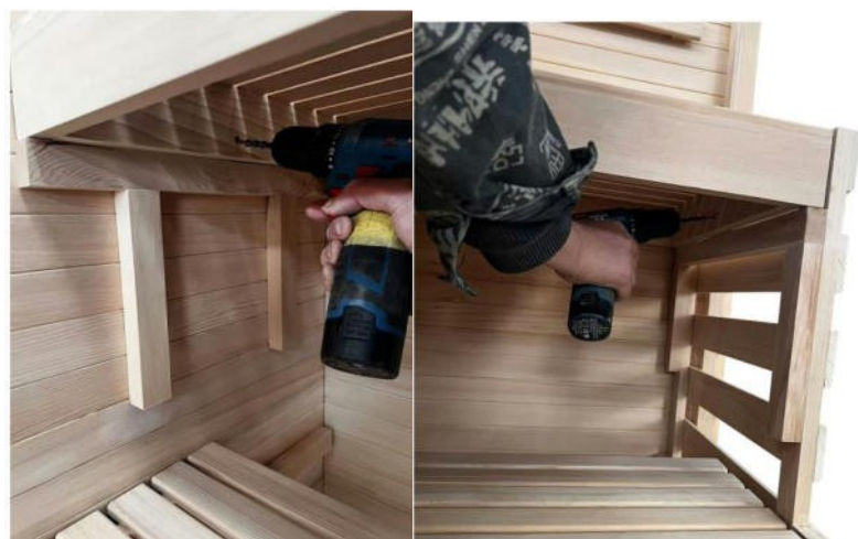
(8) Utilizzare viti per fissare il lato sinistro e destro sotto la panca, vedere le foto sopra, utilizzare viti da 4x50 mm
