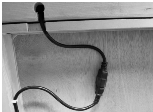
(1) Collegare i connettori dei cavi del riscaldatore, Assicurarsi che i cavi non rimangano schiacciati tra pannello del soffitto e gli altri pannelli.
