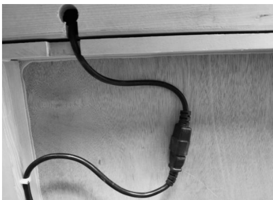
(1) Collegare i connettori dei cavi del riscaldatore, controllo. Assicurarsi che i cavi non rimangano incastrati tra pannello del soffitto e gli altri pannelli.
