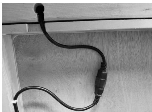
(1) (1) Zasuňte zástrčky vykurovacích káblov (uistit zovreté stropným panelom alebo inými).
