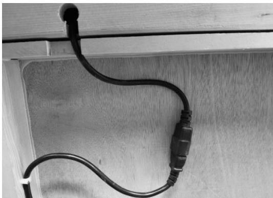
(1) spojite konektore kabela grijача, pazite da kabeli nisu uhvaćeni između stropnog i drugih panela
