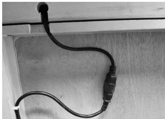
(1) (1) Zasuňte zástrčky topných kabelů (ujistěte se, přiskřípnuty stropním panelem nebo jinými).
