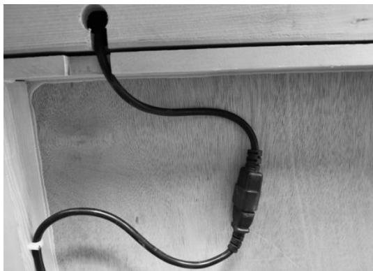
(1) Csatlakoztassa a fűtőelemek kábelét.
