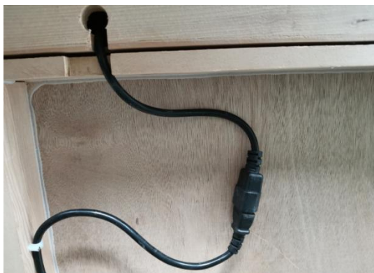
(1) spojite konektore kabela grijača, pazite da kableli nisu uhvaćeni između stropnog i drugih panela
