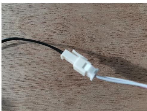
(1) Priključite konektorje kablov grelca, prepričajte se, da kabli niso ujeti med stropnim panelom in ostalimi paneli
